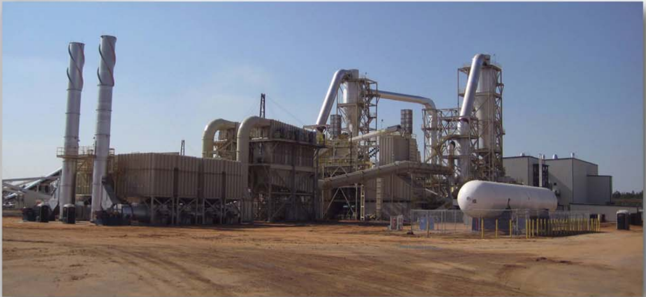
Завод по производству древесных пеллет, Флорида
