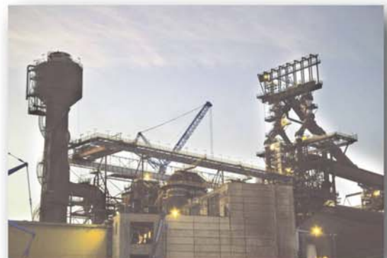
Металлургический завод Вест, Линц/Австрия
